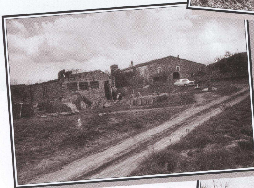
Regadiu de Juià, caseta de serveis en fase de construcció, l'any 1959. A la dreta de la caseta apareix la masia de Can Taberner.
