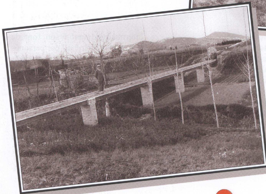
Regadiu de Juià, pous sifó -camí fondo- construïts amb les escales d'accés sobre els marges, l'any 1959.
