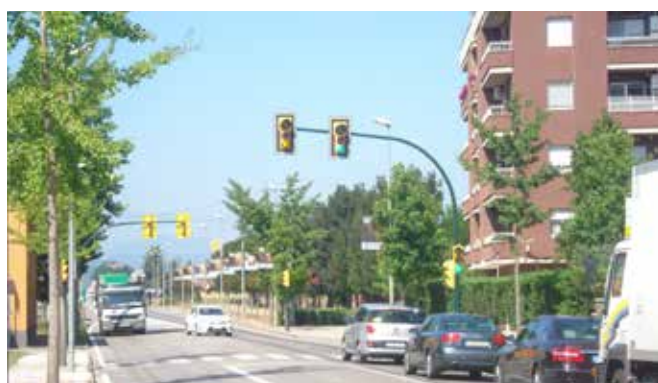
Vista actual del conjunt semafòric. Semàfor del carril en direcció Girona o la Bisbal en verd, mentre que el del carril d'accedir a la Carretera Vella o al carrer Montserrat està intermitent en groc.
