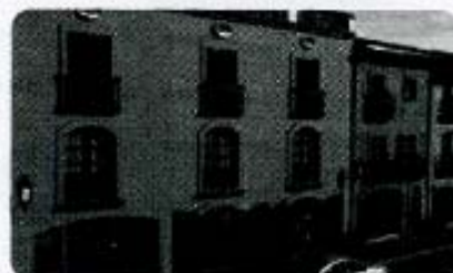
EDIFICI LA CREU BORDILS
